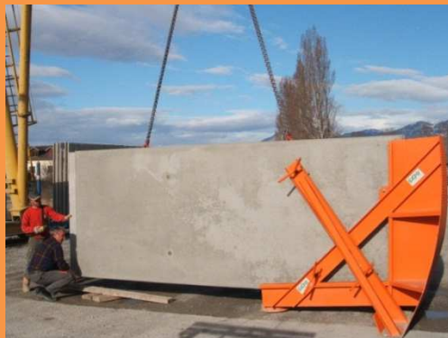
1. Positionnement du Prémur A2C dans le retourneur.
