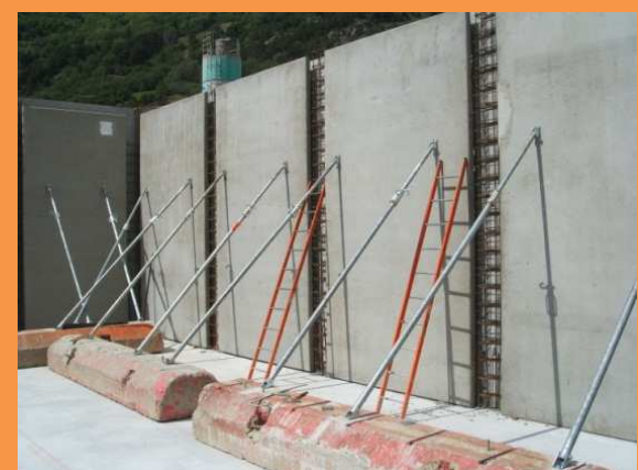
Etalement sur blocs béton
