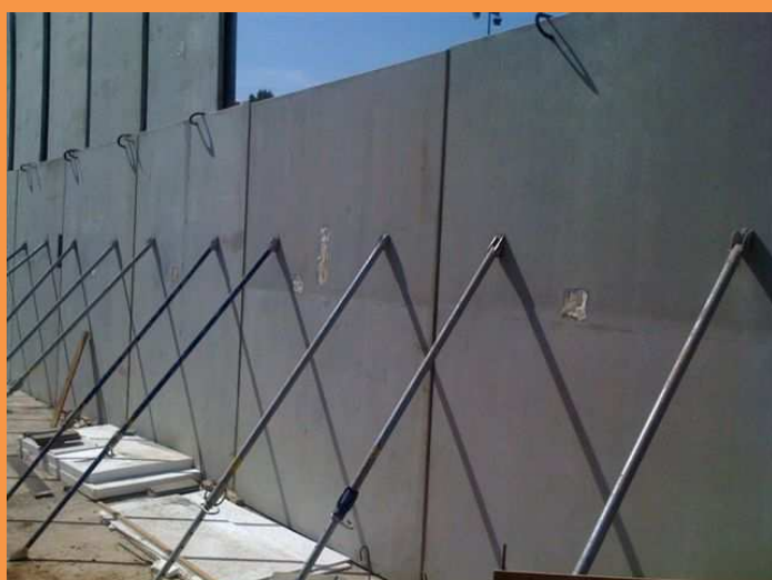
Etalement sur dalle
