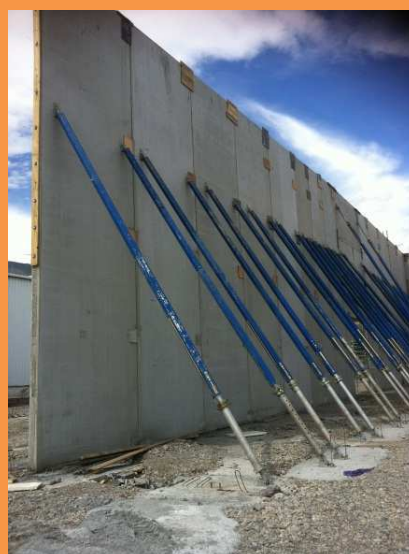
Etalement sur fondations
